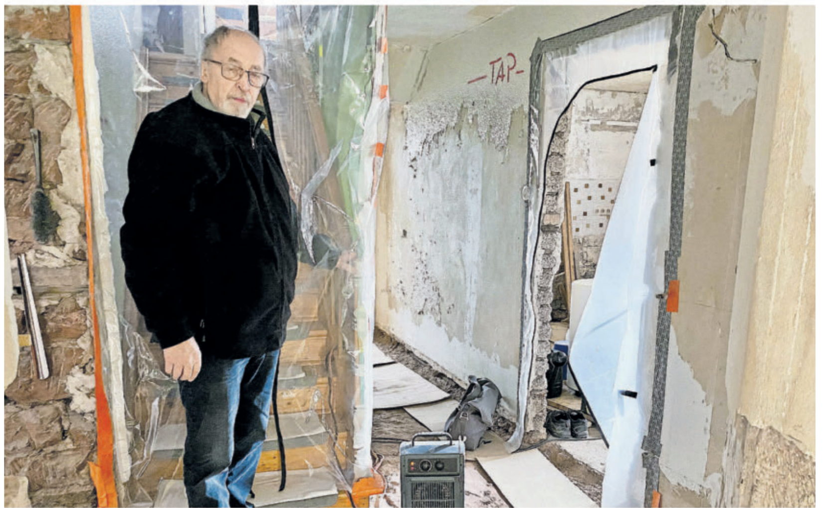
Das Erdgeschoss im Haus von Horst Lorig ist durch das Hochwasser unbewohnbar geworden.
