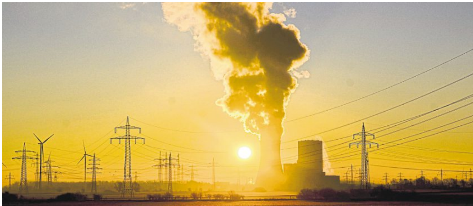
Während die Atommeiler vom Netz gehen, kehrte das Kraftwerk Mehrum im niedersächsischen Kreis Peine wieder zurück. Eine Verordnung hatte erlaubt, dass Steinkohlekraftwerke aus der sogenannten Netzreserve wieder in Betrieb gehen konnten, um Erdgas einzusparen. Foto: Julian Stratenschulte/dpa
